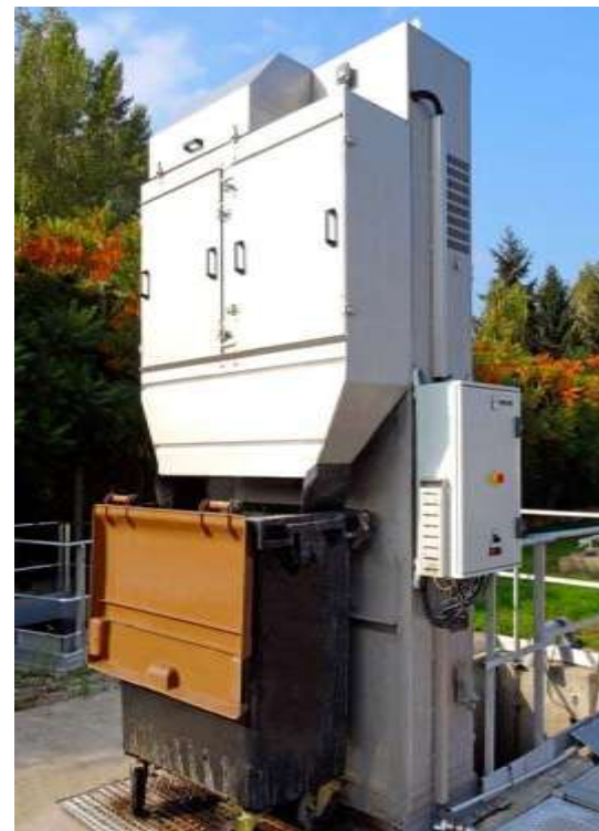
DEGRILLEUR VERTICAL A CABLES
